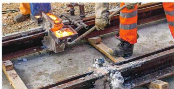
Pour souder les rails de chemin de fer, un procédé d'aluminothermie est utilisé.
